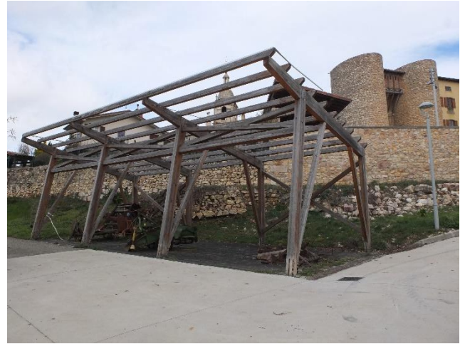
FIGURA 2: Estructura desprovista de cubierta
